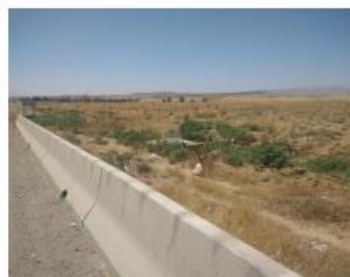
FIGURE 17 VUE SUR LE TERRAIN DE L'INTERVENTION SOURCE AUTEUR 2020
