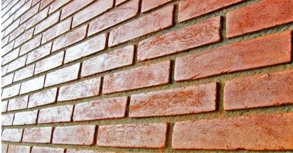
**Figure N°174: mur en brique de terre cuite**
