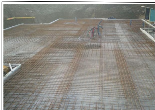
Figure2 : fondation en radier en travaux.
