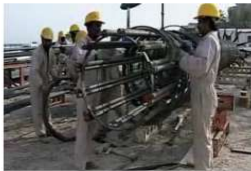
Figure 59 : L'armature principale des pieux.
