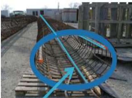
Figure 59 : L'armature principale des pieux.
