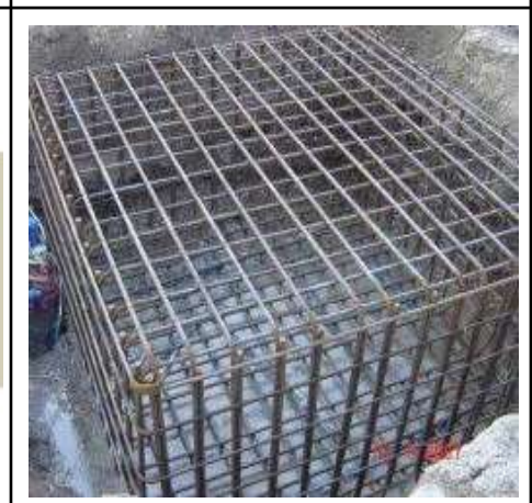
Figure 53: Socle en béton armé
