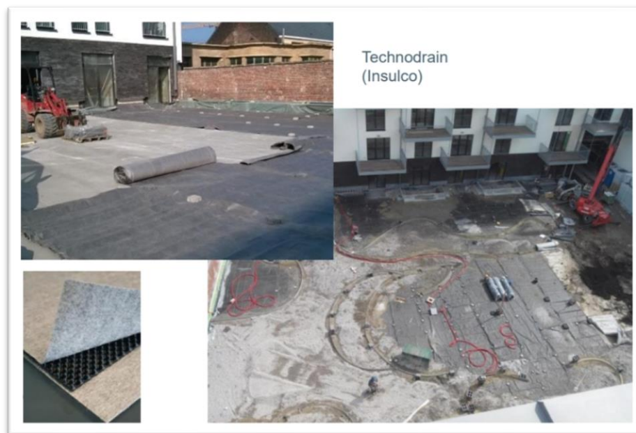
Figure N° 64 : Travaux d'aménagement et dispositifs en cours
