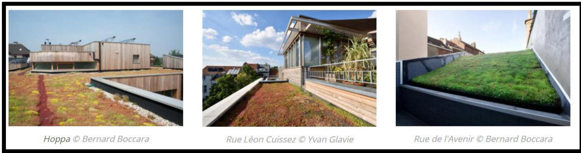
Figure N°24 : Exemples de végétation sur toitures vertes extensives
