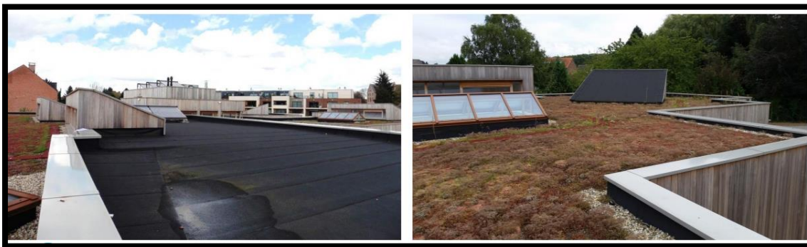
Figure N° 54 : Toitures non revêtues et toitures vertes de collecte d'eau pluviale
