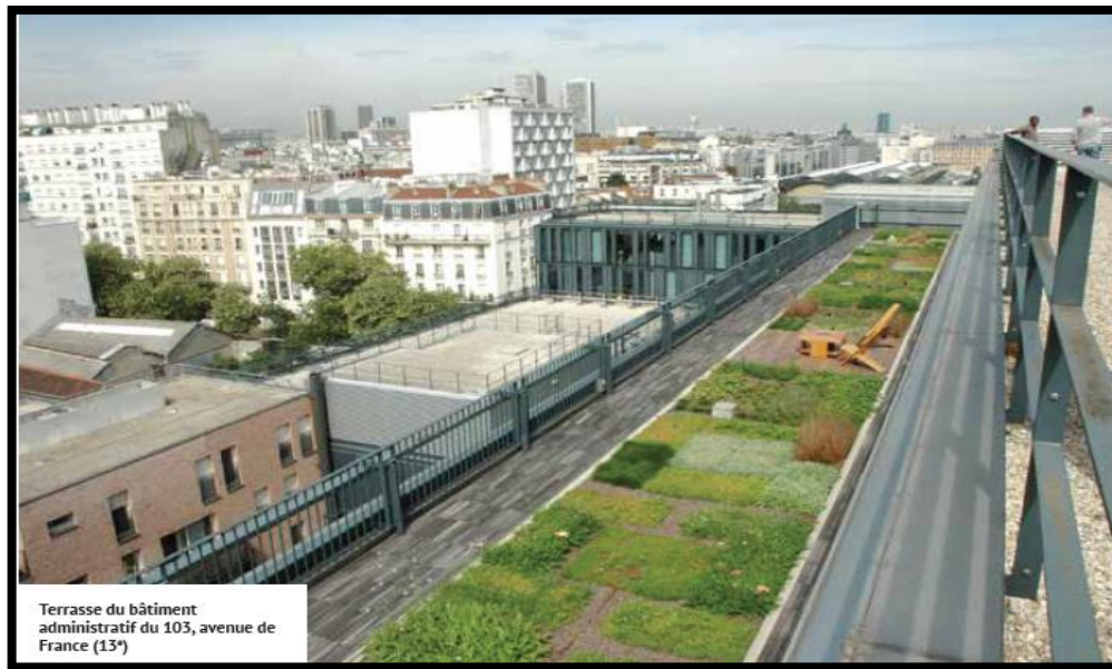
Figure N°26: Toiture végétalisée semi –intensive
