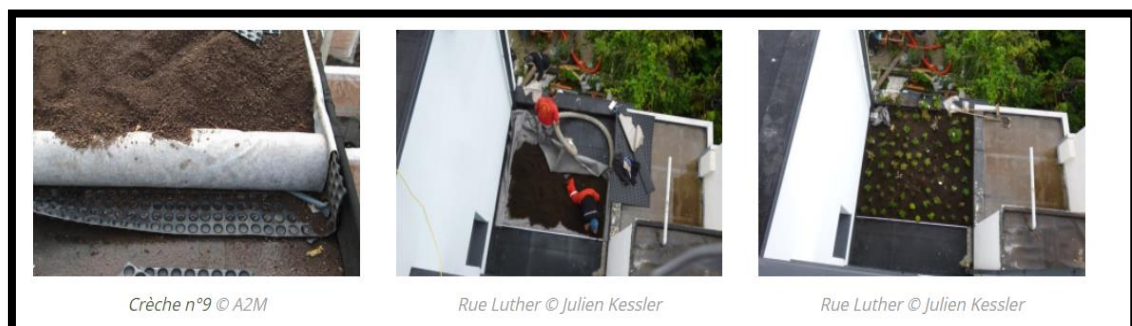
Figure N°23: mise en œuvre d'une Toiture végétalisée extensive
