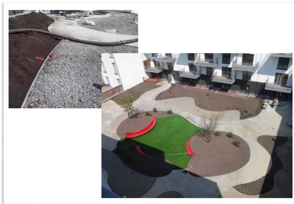
Figure N° 65 : Travaux d'aménagement et dispositifs en cours
