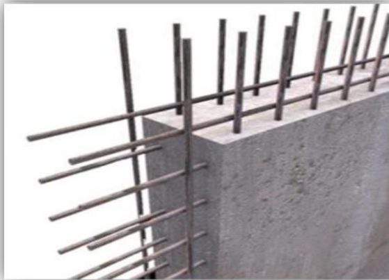
Figure 86 : Voile en béton armé Source : travauxbeton.fr
