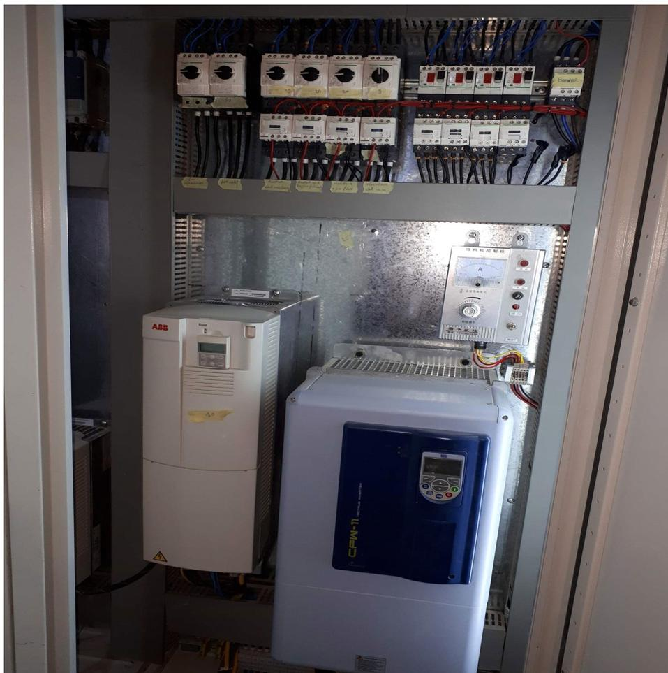
Figure 2- 10Variateur de vitesse ABB acs800 et cfw-11
