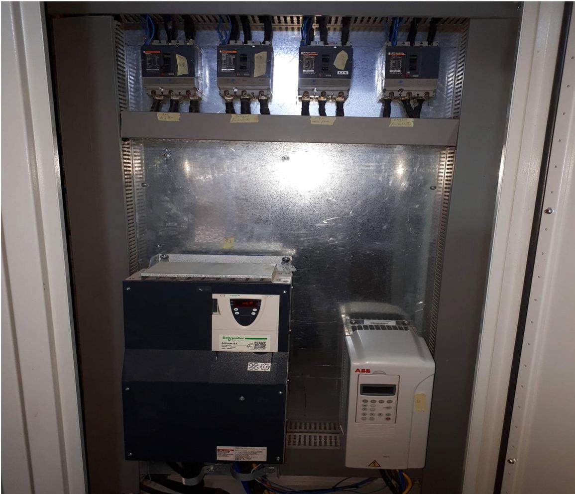
Figure 2- 11Variateur de vitesse ABB acs800 et altivare61
