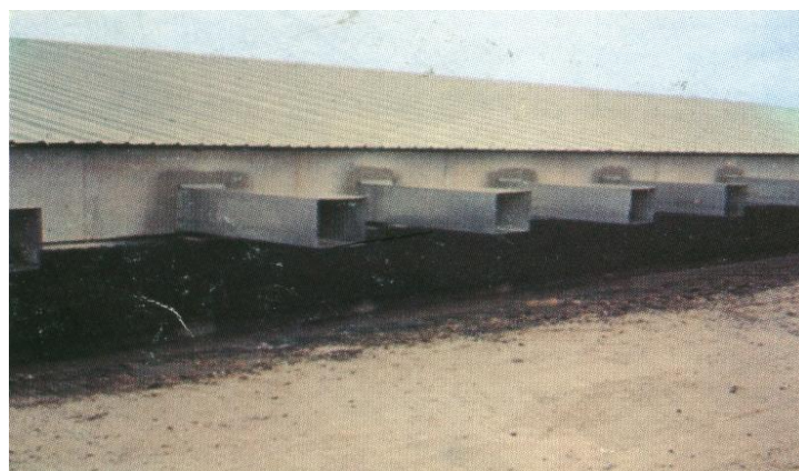
Figure n°05 : Orifice à ventilation dans un poulailler à ventilation mécanique (BOITA.R, VERGER.M, LECER Y, 1983).
