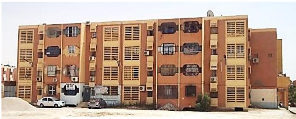
Figure III.13 forme et position des balcons
