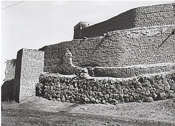
Figure II.13 Mur des fondations en troncs de palmiers
