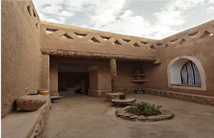
Figure 1.9 : La cour d'une maison à Timimoune.
