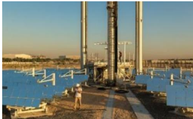
Figure 2.13 : Les panneaux photovoltaïques. Source: www.webdeveloppementdurable.com
