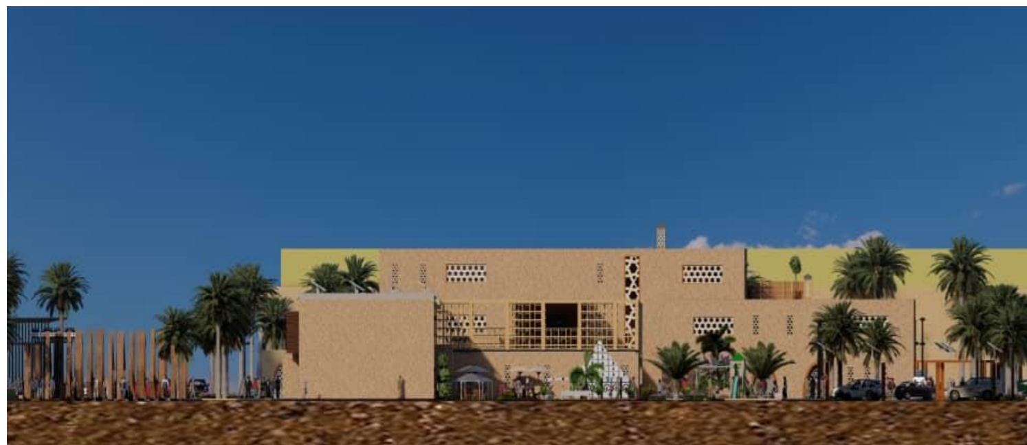
Figure 6. 31 : Façade Nord- Ouest du centre d’artisanat traditionnel. Source : Auteurs/ année 2021
