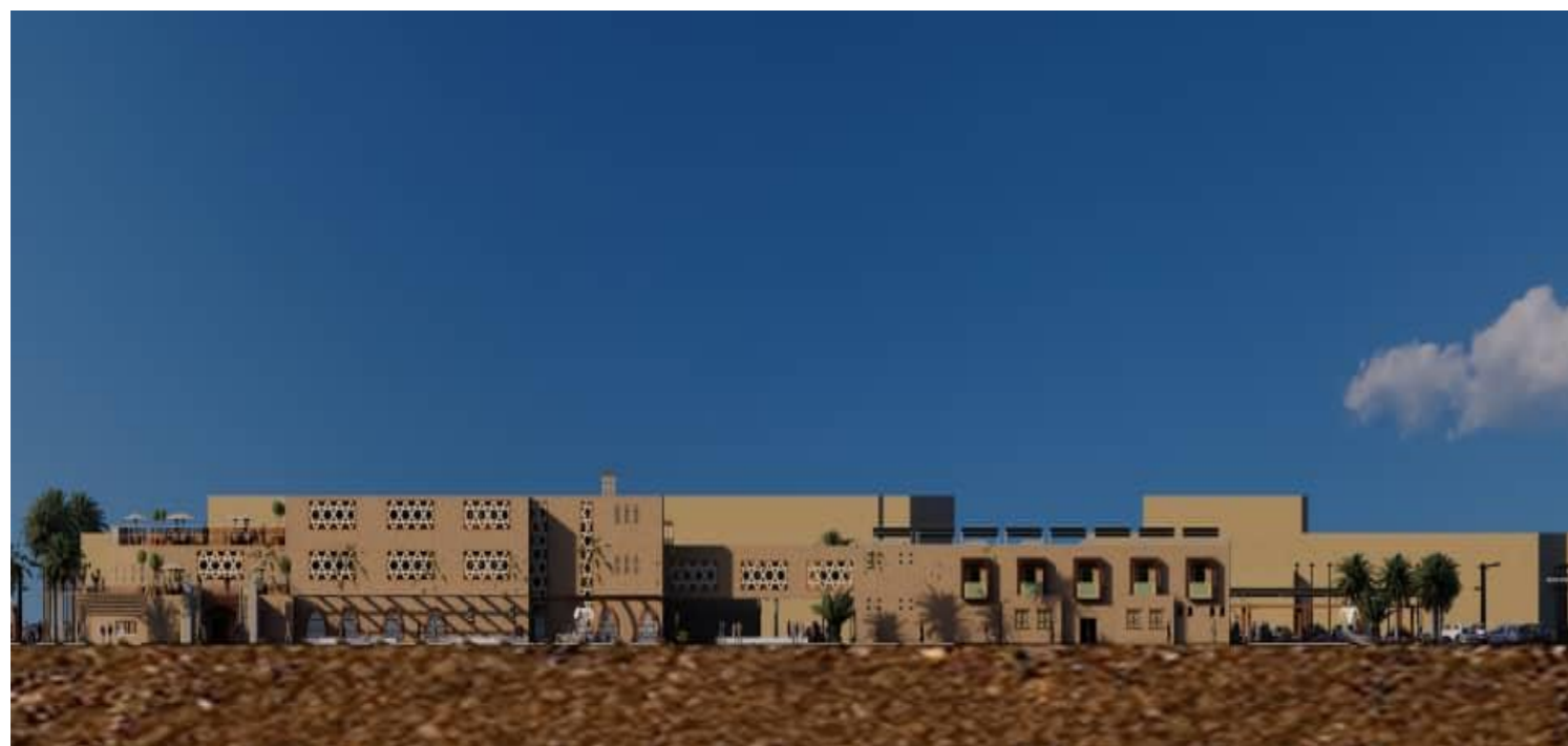
Figure 6.33: Façade Nord-Est du centre d’artisanat traditionnel. Source : Auteurs/ année 2021
