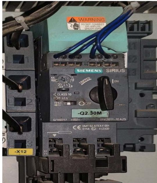
Figure III.6. Disjoncteur moteur.
