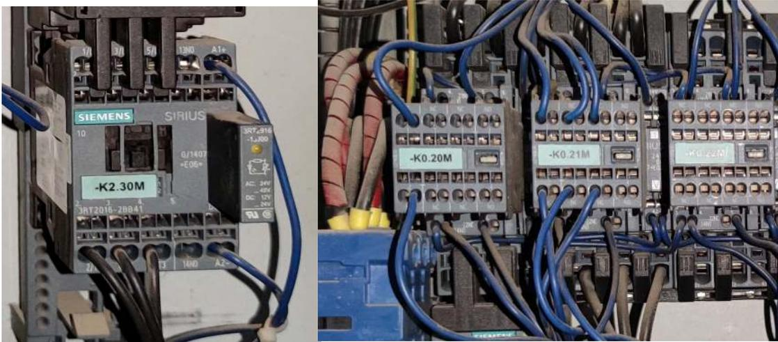
**Figure III.3.** Contacteur de puissance.
