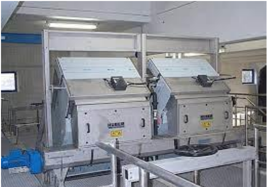
Figure 2. 3: dégrilleur escalier vu arrière
