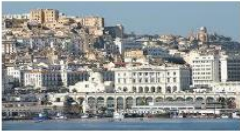
Fig 49: la façade maritime de la baie d'Alger/ Algérie
