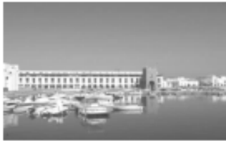
Fig.85 : -Complexe de Sidi-Fredj par Fernand POUILLON.
