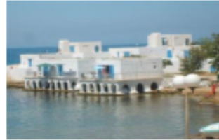
Fig.86 : Complexe de CET par Fernand POUILLON
