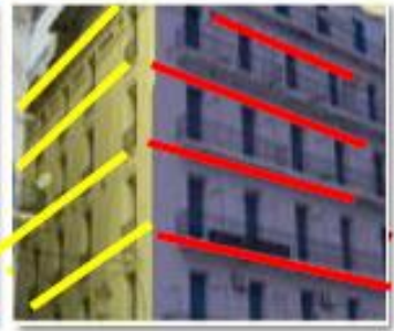
Fig 59:immeuble ,rue hassiba benbouali
