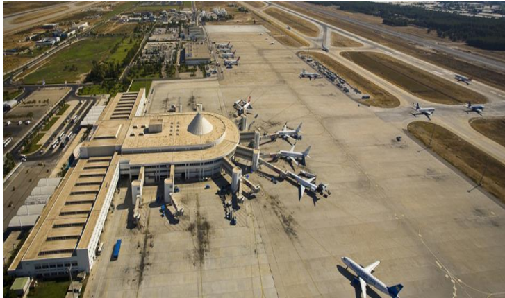
Figure I-12 : Aire de stationnement
