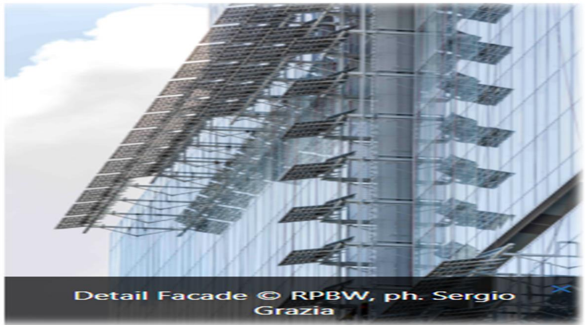
figII-6/ façade et détails pano photovoltaïques
