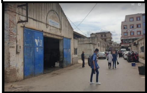
Figure 105 : Friche N02 hangar mécanicien)
