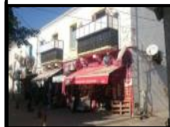
Figure75: Maison colonial R+1
