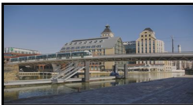
Figure12: La reconversion des grands moulins de Pantin en pôle tertiaire, symbole de la requalification du quartier. Source: Phot. Sattler, Caroline. © Reichen et Robert & Associés Architectes-Urbanistes
