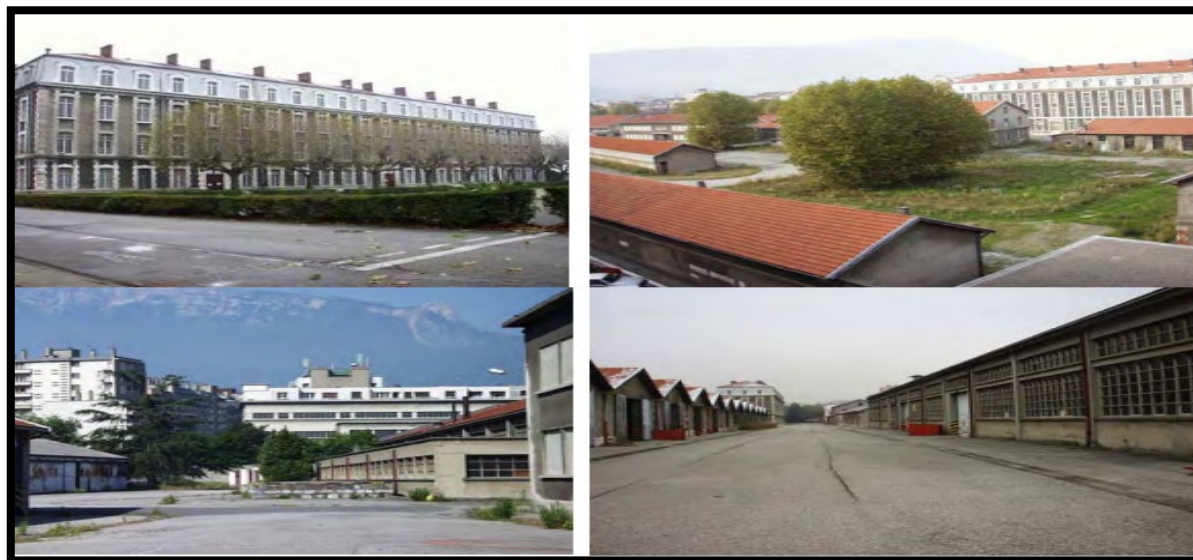
Figure 17:Vue façades avant la
