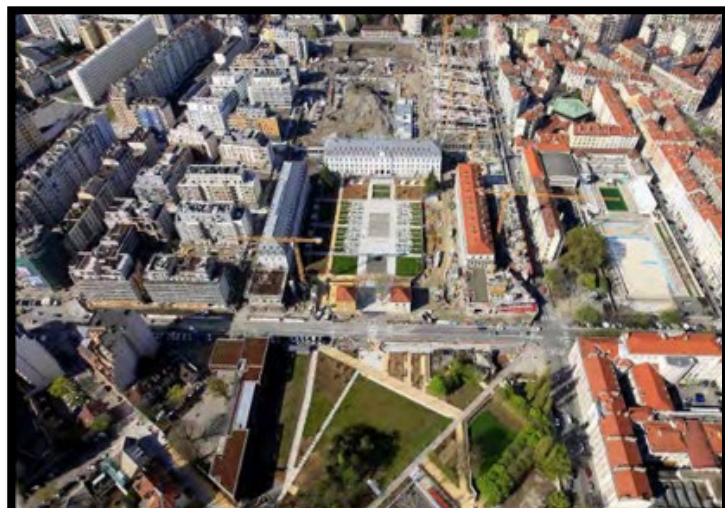
Figure18:Vue projet avant la reconversion
