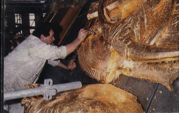
Douze kilos et demi d'or répartis en 550 000 feuilles de 0,2 micromètre d'épaisseur sont en train d'être collées une à une sur le dôme des Invalides. Lever de rideau en juillet. p. 102
