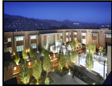
Figure 19 : vue sur la cour de l'hôpital
