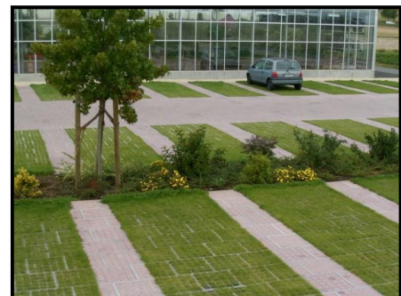
Figure 84 : revêtement de parking perméable ; source : google image
