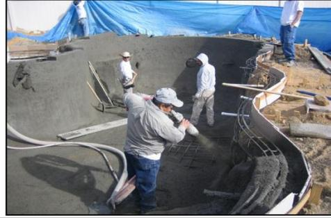
**Figure19 :Piscine en béton projeté**
