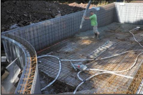
**Figure18 :Piscine en béton coulé**
