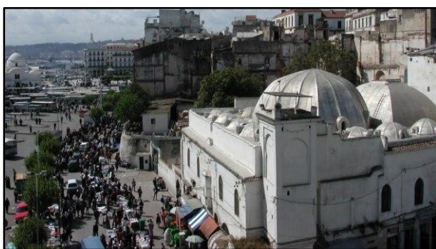
FIG I.4 : La mosqué Ali Betchine et le site d'intervention Source : https://s-i.huffpost.com/gen/3319966/images/n-BETCHINE-MOSQUE-628x314.jpg
