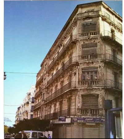
Figure II.17 : Immeuble de la Parisienne 8 rue Sergent Addoun, Alger centre
