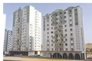
Fig n°23 : Logements AADL à Sidi-Abdallah
