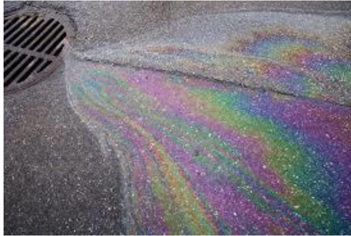
Figure 6 : Un déversement de carburant
