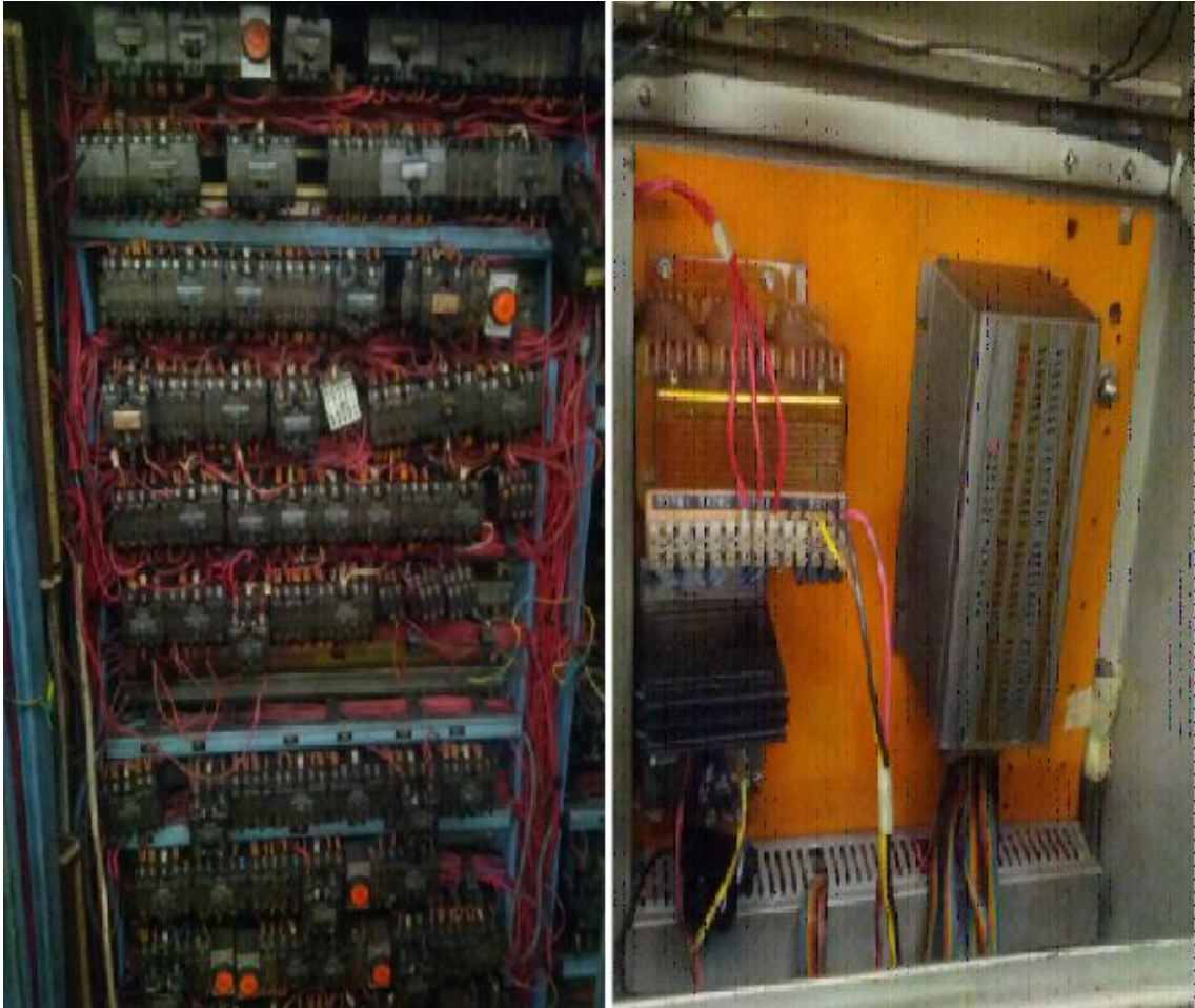
Figure3.1 : la différence entre automatisation avec API et logique câblé.
