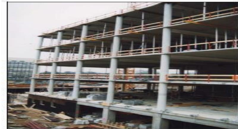
**Figure II.2 : Poteaux et dalles sur chantier (Citibank Duisburg, Allemagne).**
