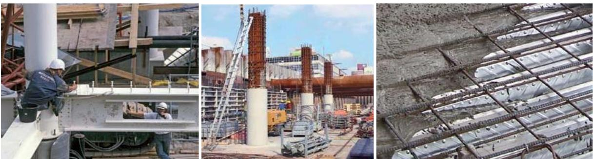
**Figure II.1 : éléments structuraux de construction mixte.**
