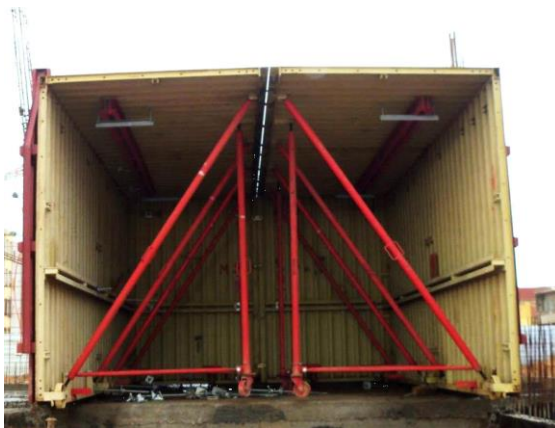
Fig I. 5: Assemblage de deux demicoquilles sur chantier
