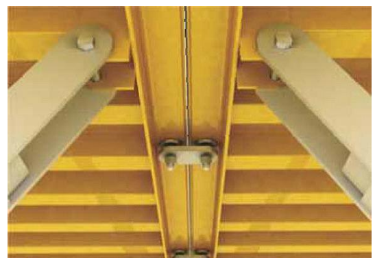
Fig I. 4: deux panneaux horizontaux solidarisés à l'aide verrous à clef
