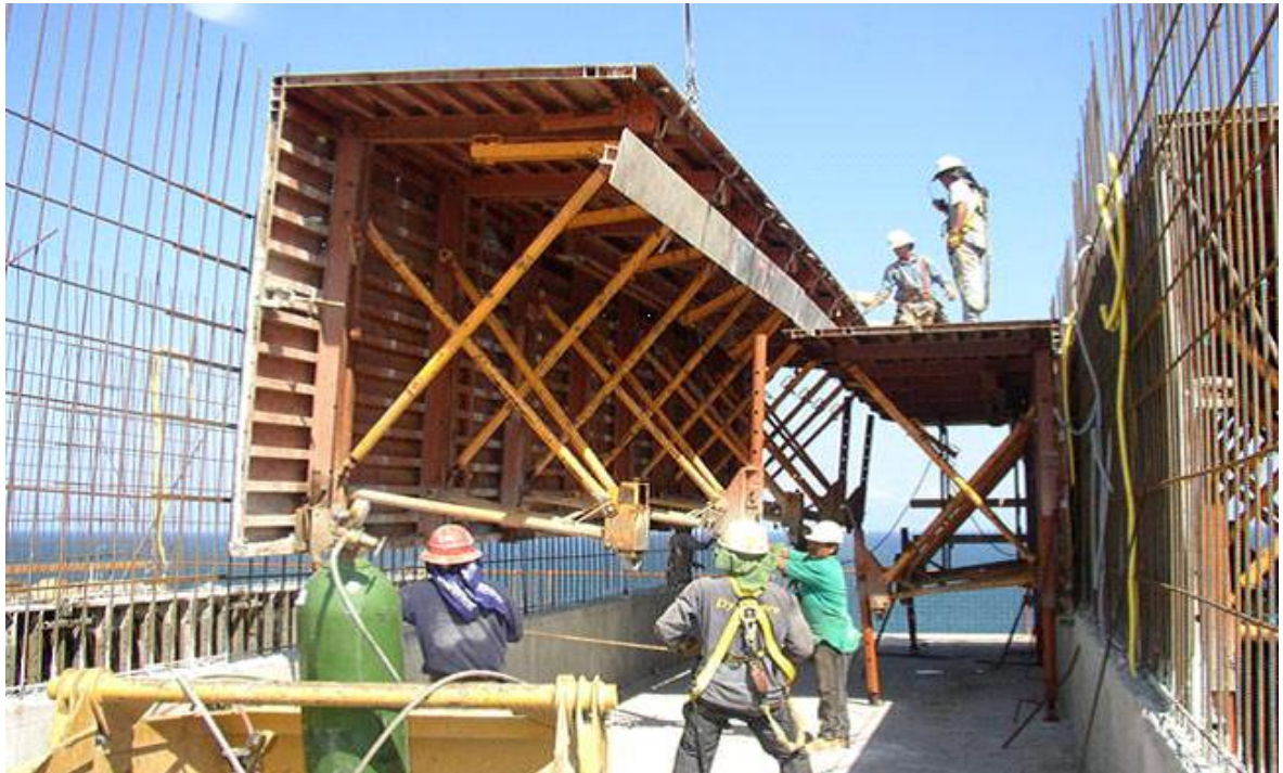
Fig I. 3: une demi-coquille sur chantier
