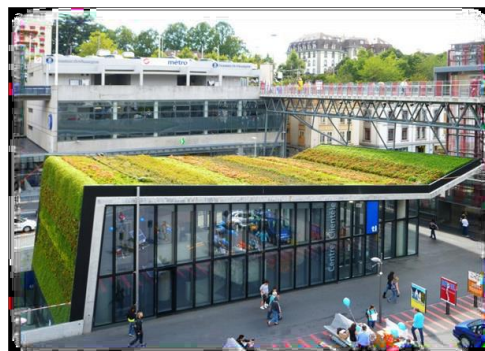
Figure 9 : toiture végétal, la gare du Flon à Lausanne en suisse.
