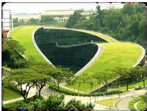
Figure 10 : toiture végétal de l'école d'art, design et media de l'université technologique de Singapour, Nanyang.
