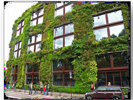
Figure8 : mur végétal du musée de Quai Branly, Paris. Source : CREPIEUX S,
