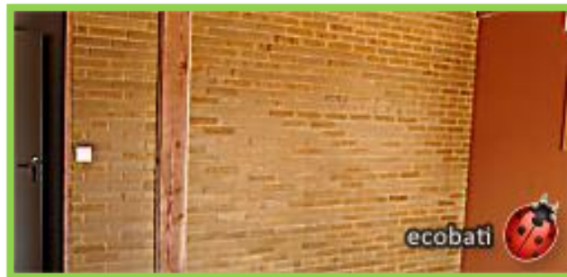
Figure 75 : Cloison en terre crue
