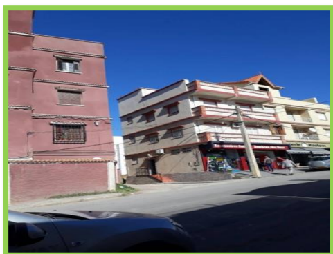
Figure 39 : Habitation individuelles Source: Auteurs, 16/03/2018
