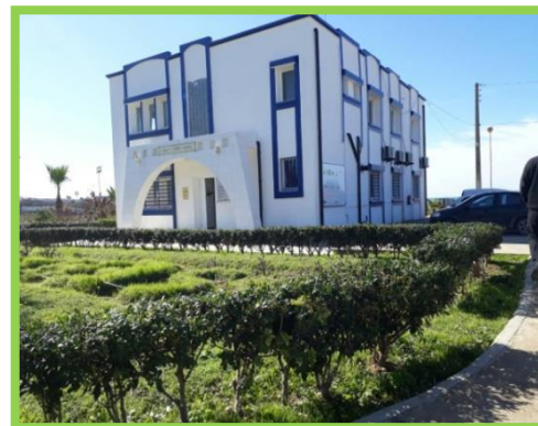
Figure 53 : Centre d'épuration SEAL Source : Auteurs
