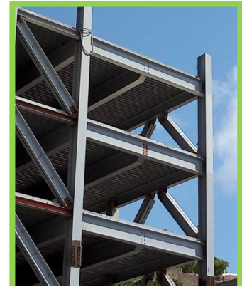
Figure 71 : Exemple de structure métallique Source: Auteurs
