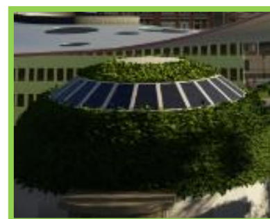
Figure 84 : Toiture végétale Source : Auteurs
