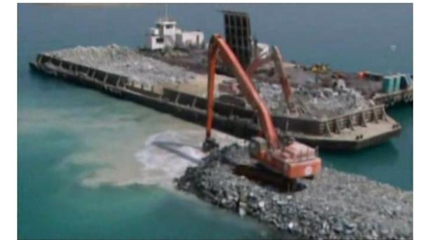
**Figure n°=24** : Montrant la 4eme étape de la réalisation de la digue de protection.
