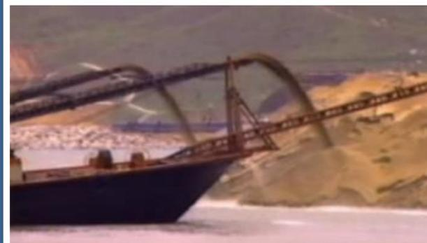
Figure n°=34 : Montrant la 4eme étape de la réalisation de l'île artificielle.
