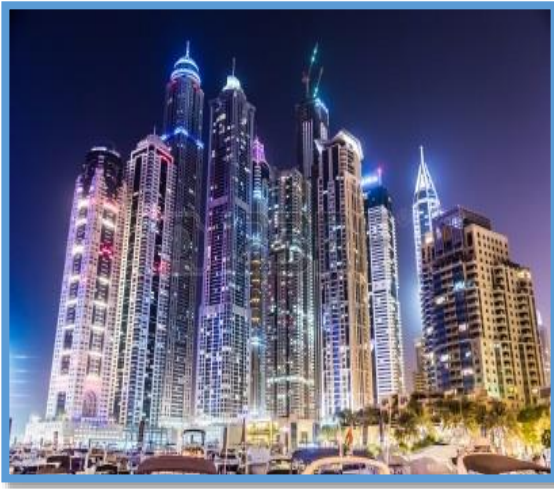
Fig 09. Ville nouvelle de Abu - Dhabi
