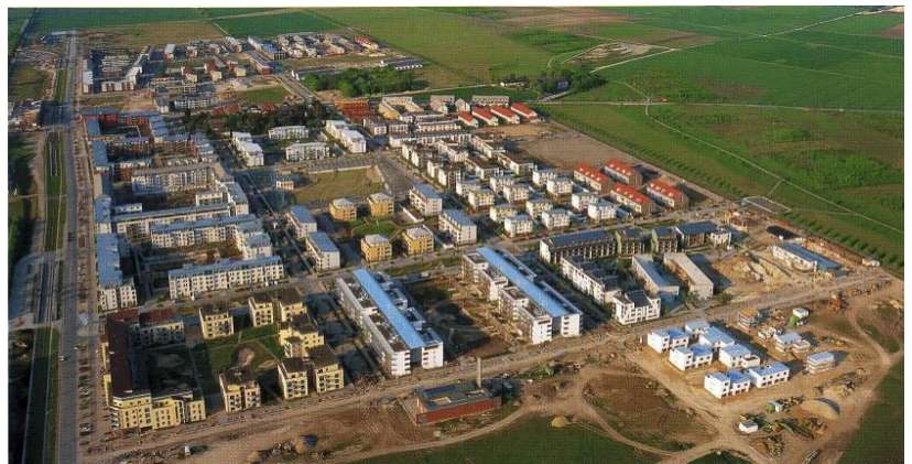
Figure 21 vue sur l'Eco quartier Hannover, 2004
