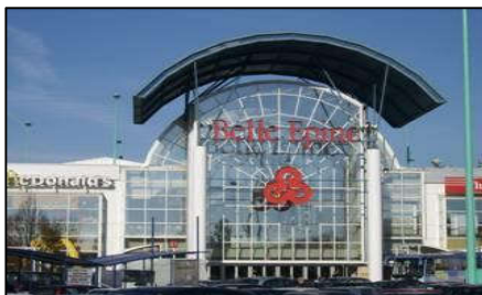
Figure 48 : Centre commercial régional - belle épine - France.
