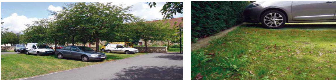
Figure 90: parking en dalle végétalisée
