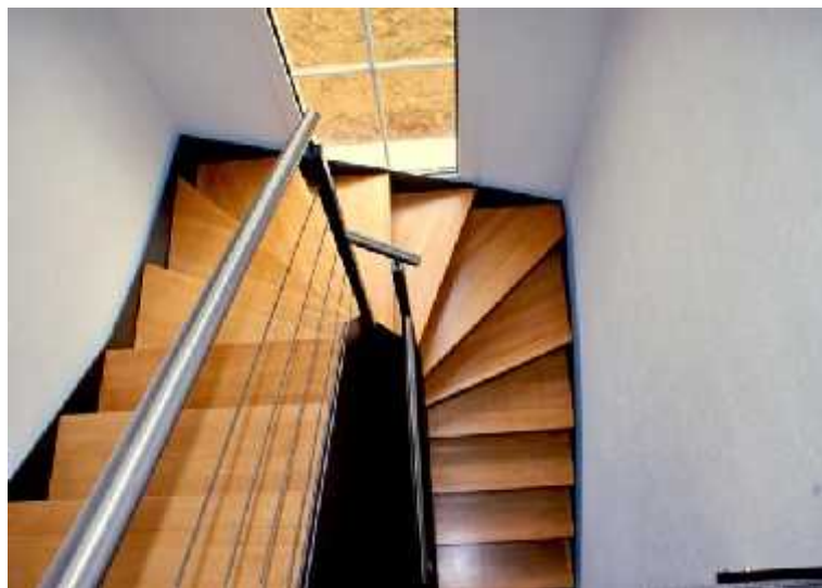
Petit escalier métallique pour le logement à caractère locatif.
