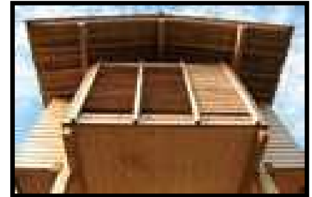
Avancées de toiture
