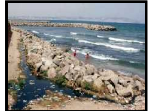
eaux usés déversés dans la mer.
