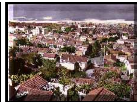
toiture en tuile rouge
