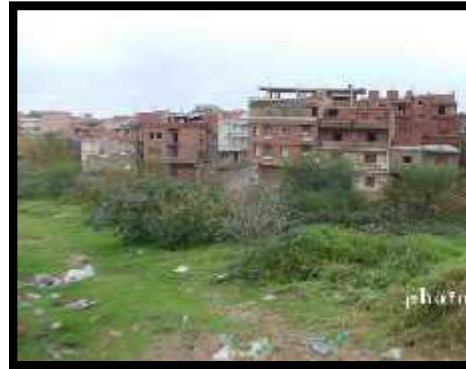
constructions sur le lit de l'oued!
