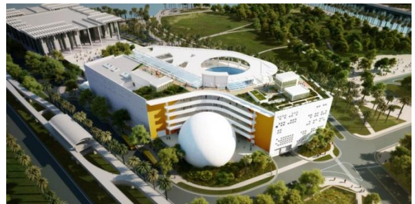
Figure 66 Vue 3D sur le musée des sciences de Miami montrant le traitement d'angle par le planétarium
