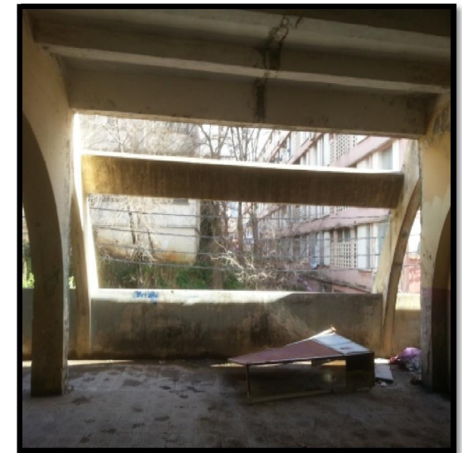
Figure 16: Installation basique en mauvaise état
