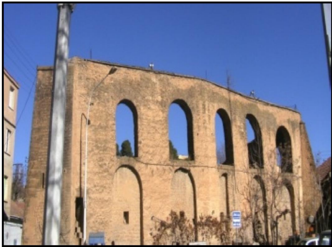
Figure 1: Le portique en arcade
