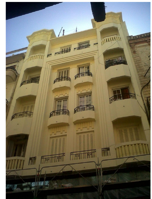
Figure 42: Bâtiments réhabilités (Algiers)
