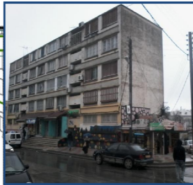
Figure 3.134 : Les logements de tahtouh
