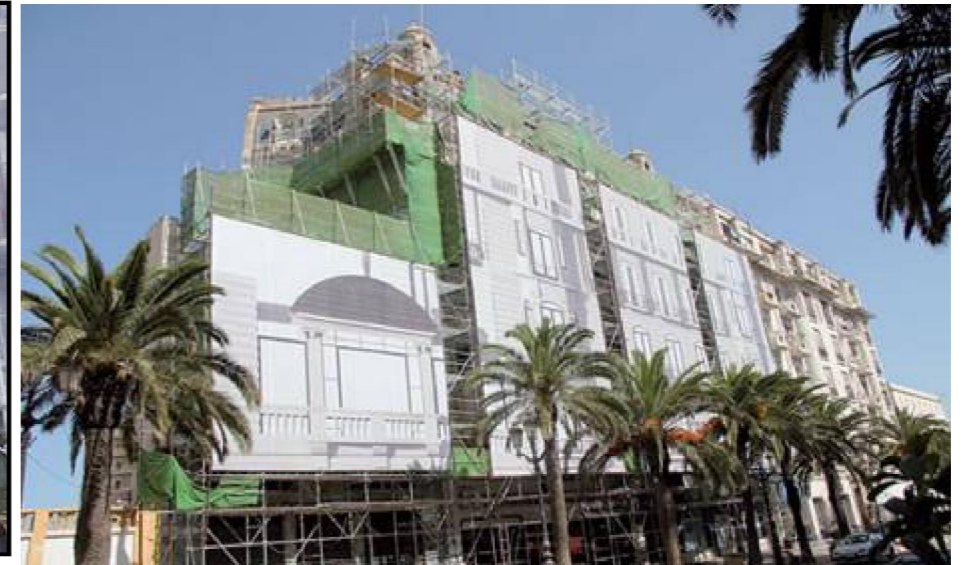
Figure 39: Bâtiment en cours de réhabilitation (Oran)
