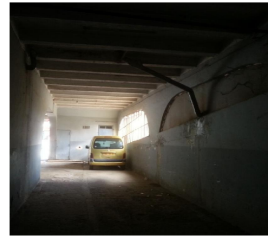
Figure 18: Installation basique en mauvaise état dans le centre commercial
