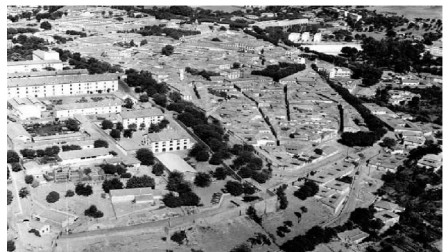
Figure 3.97: vue De la caserne
