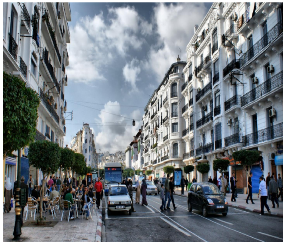
Figure 40: Bâtiments réhabilités (Algiers)
