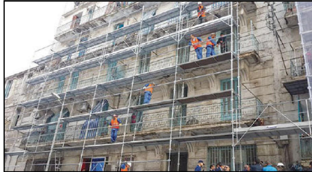
Figure 38: Bâtiment en cours de réhabilitation (Algiers)
