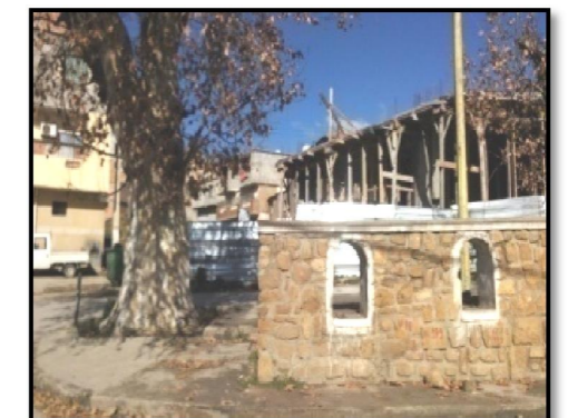
Figure 3.25: Vue sur porte de sidi sahraoui
