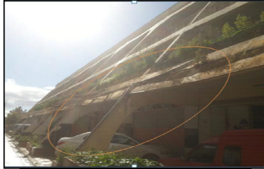
Figure 3.169: Installation basique en mauvais état
