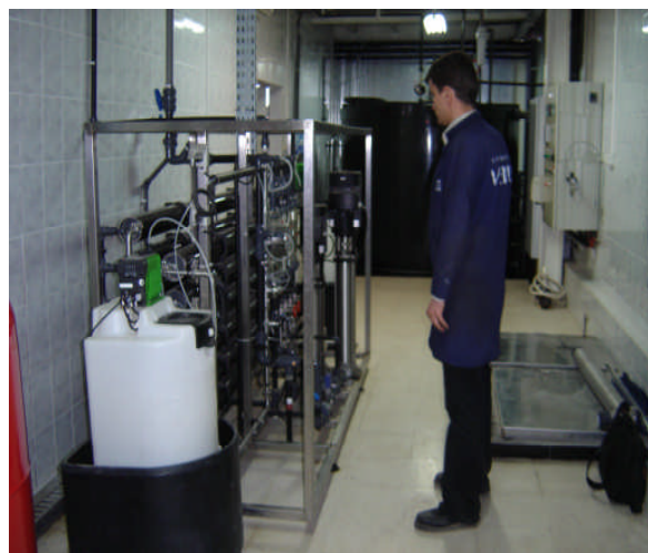
Figure 31 : M. Nacer Ounesli, Ingénieur en mécanique L'ange gardien de la salle de traitement des eaux ©ZM
