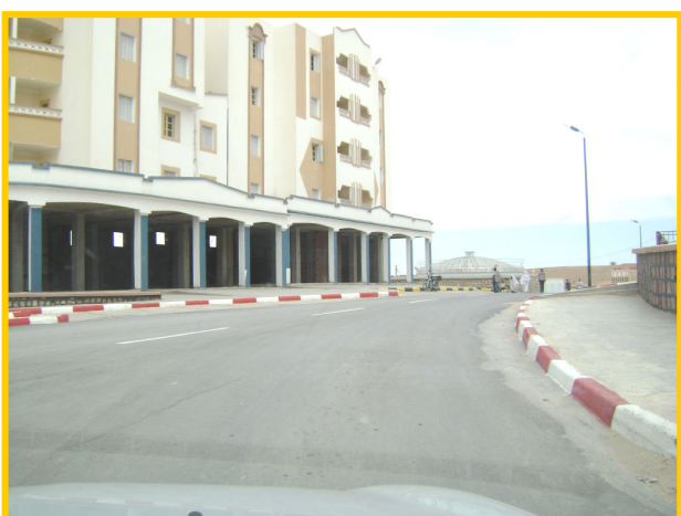
Fig.29: Logements sociaux dans la cité Ain Srar
