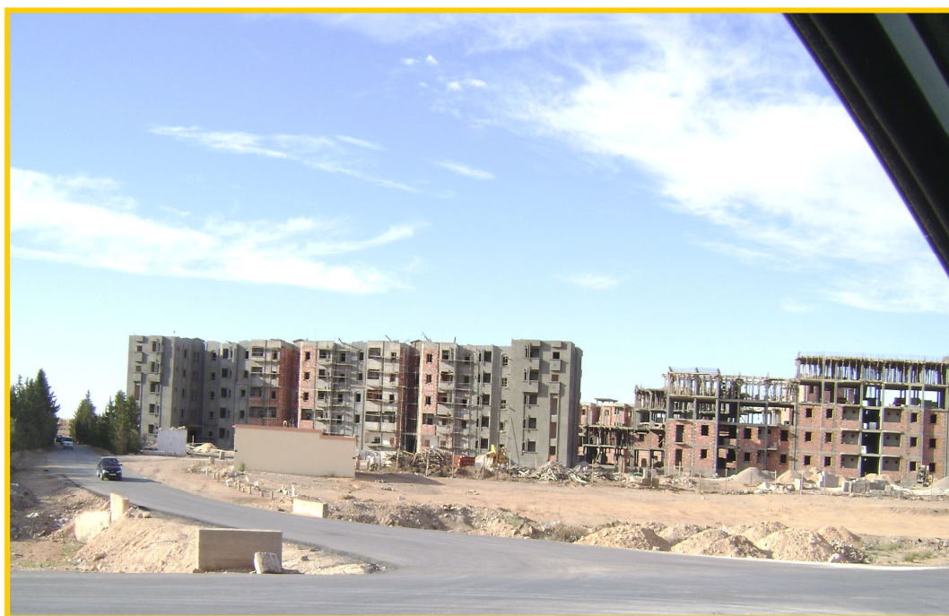
Fig.45: Logements sociaux en construction suivis par le bureau d'étude géré par Amraoui Benyoucef "Cité des jardins"
