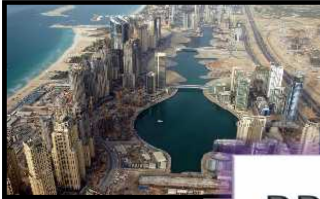
1-Pole de plaisance Nakhilt-tower Situation: Dubaï
