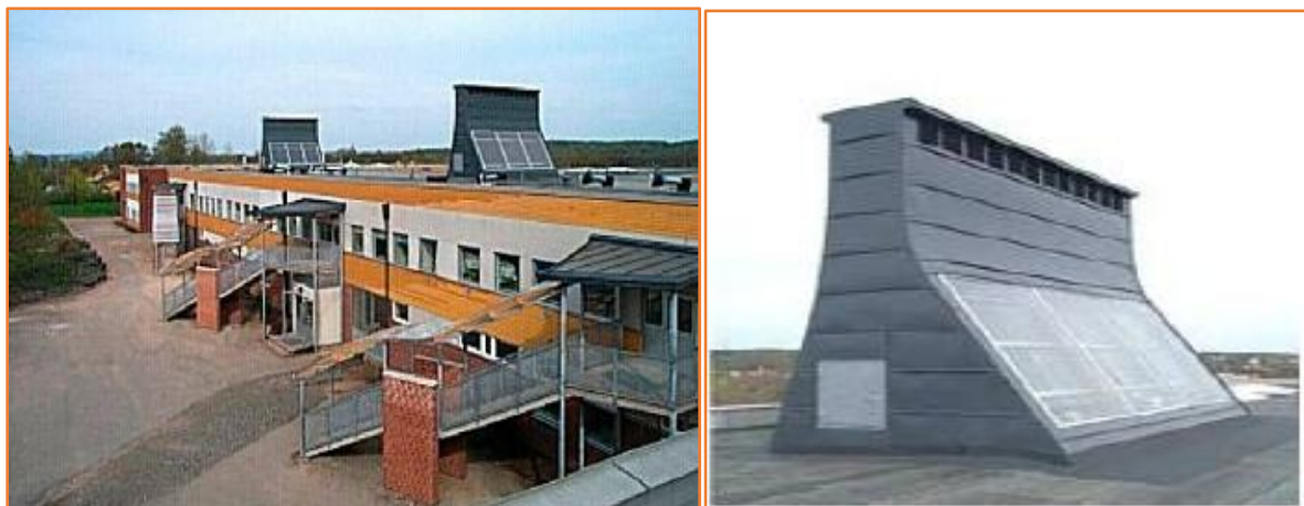
Fig. 24: Présentation d'une cheminée solaire à l'école Tanga
