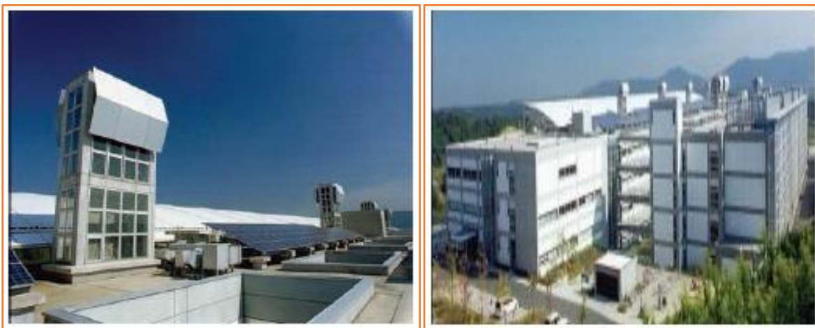
Fig. 23: Exemple de cheminée solaire intégré sur le bâtiment
