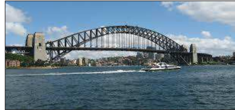
Figure 60 : PONT DE SYDNEY Source :Google image
