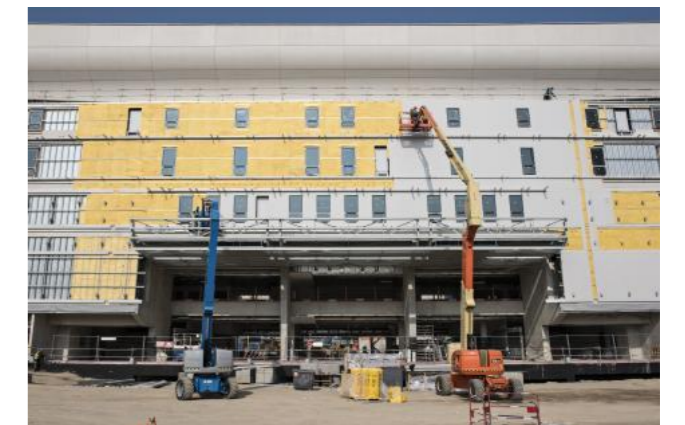
Figure 99 : pose de l'isolation pour le Stade Aréna 92 (140)
