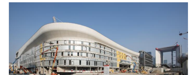
Figure 97 : stade Aréna 92 impose importante contrainte acoustique (140)
