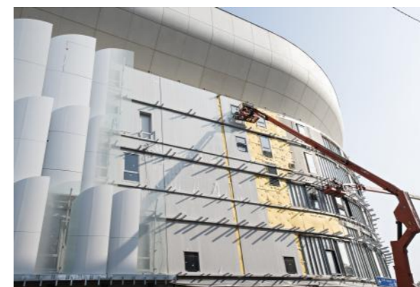
Figure 98 : la pose de l'isolation Aréna 92 (140)
