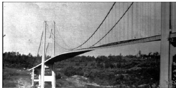
Figure (I.3) : Déformations du tablier de l'ancien pont de Tacoma Narrows en cours de flottement.
