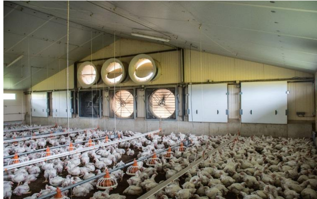
Figure 2.10 Ventilation dynamique. (I.T.A.B, 2009).
