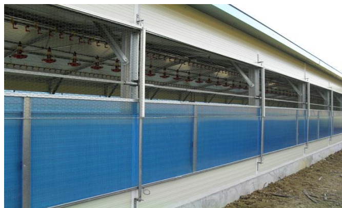
Figure 2.9 Ventilation statique. (I.T.A.B, 2009).
