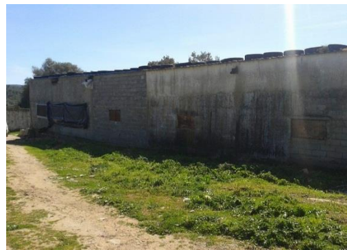
Figure 3.4: bâtiment en parpaing
