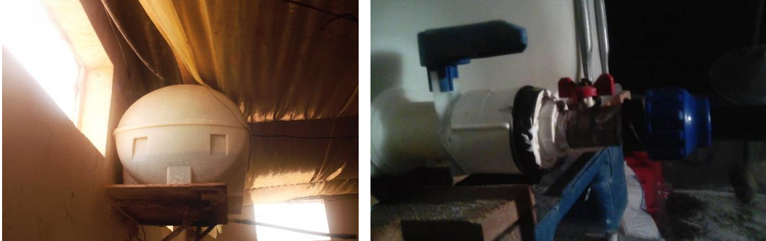
Figure 3.9: Installation de citerne en plastique.
