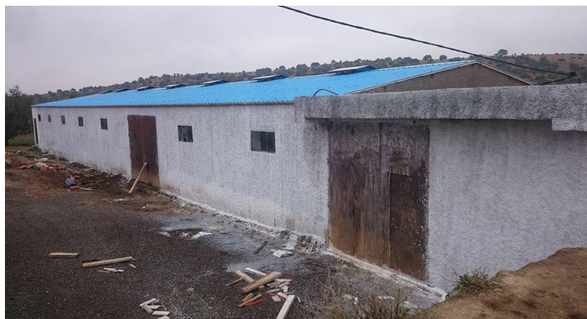
Figure 3.2: bâtiment de poulet de chair dans une zone rurale.
