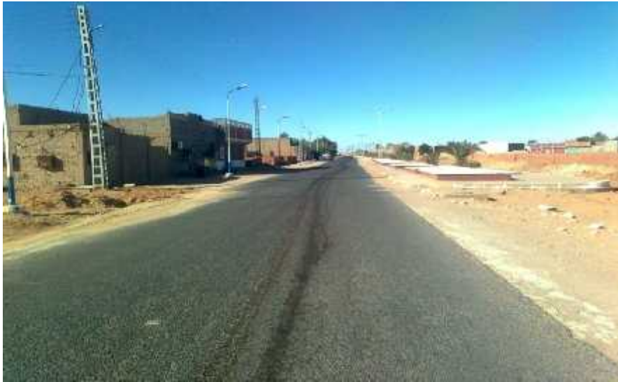
Fig : une voiesecondaire. (Source : photo prise par les auteurs).
