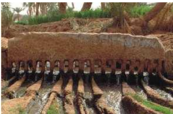
Fig. : Peigne répartiteur (Kasria) Fig. : Bassin terminal (Magen)
