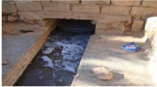
Fig : vue externe de la foggara (Source : photo prise par les auteurs)
