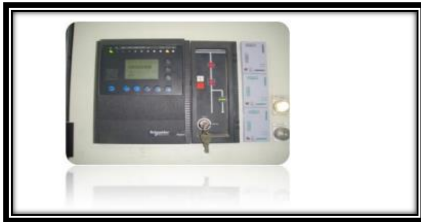
Figure 3.3 : Exemple de relais numérique (SEPAM de Schneider Electric)
