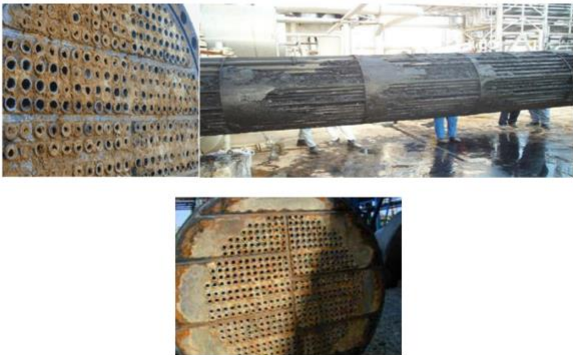
Figure (I.15) : exemple sur l'encrassement.
