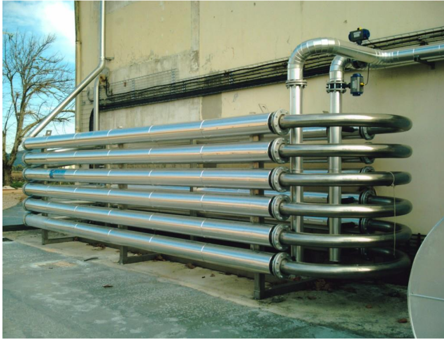
Figure (II.1) : échangeur coaxial
