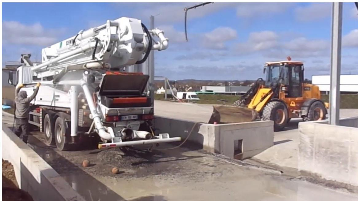
Figure 4. 2: Lavage d'une pompe à béton
