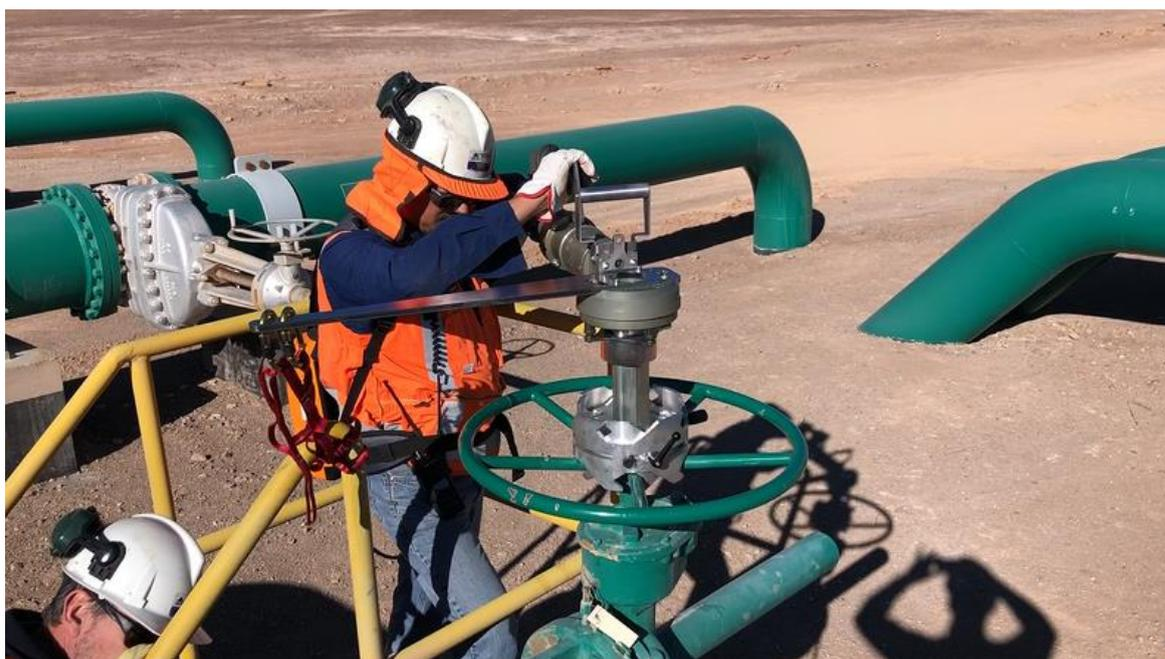
**Figure 3. 10: Opération de maintenance rapide et sécurisée effectuée dans une mine au Chili grâce à un actionneur de vannes portable Modec.**
