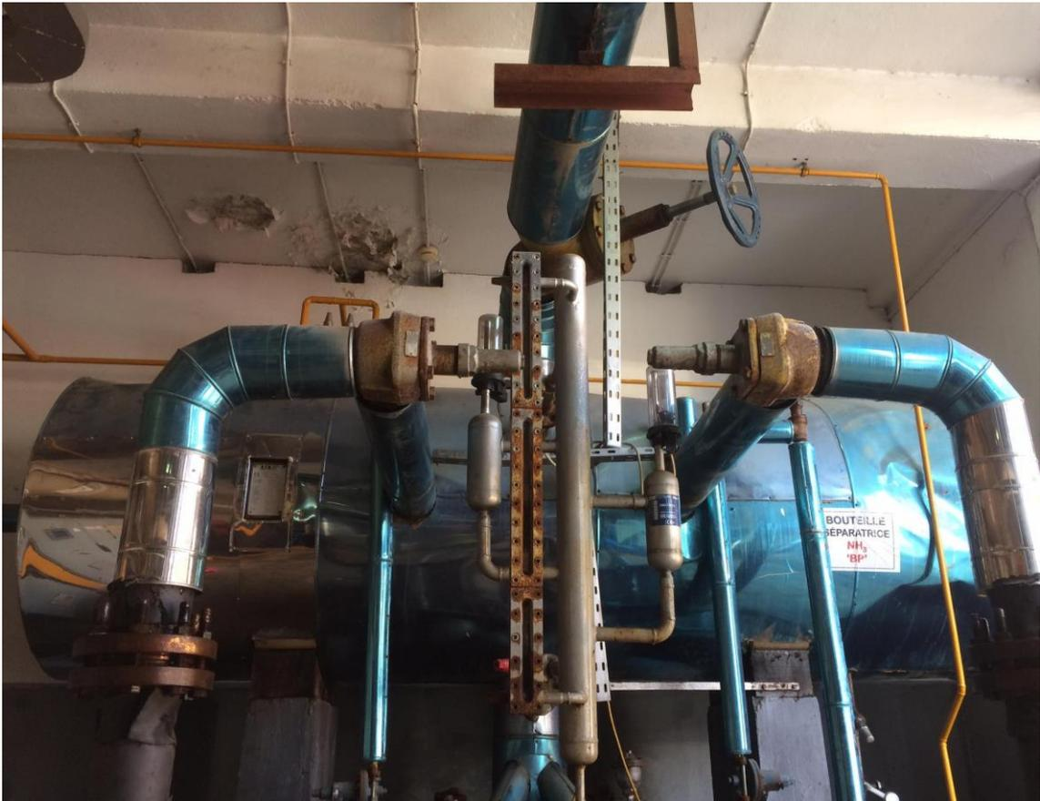
**Figure 2.21** : Une vue réelle d'une bouteille séparatrice BP.
