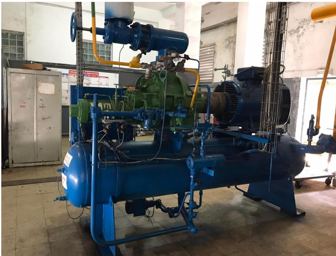
**Figure 2.9 :** Une vue réelle d'un compresseur à vis avec son moteur électrique et son séparateur d'huile.
