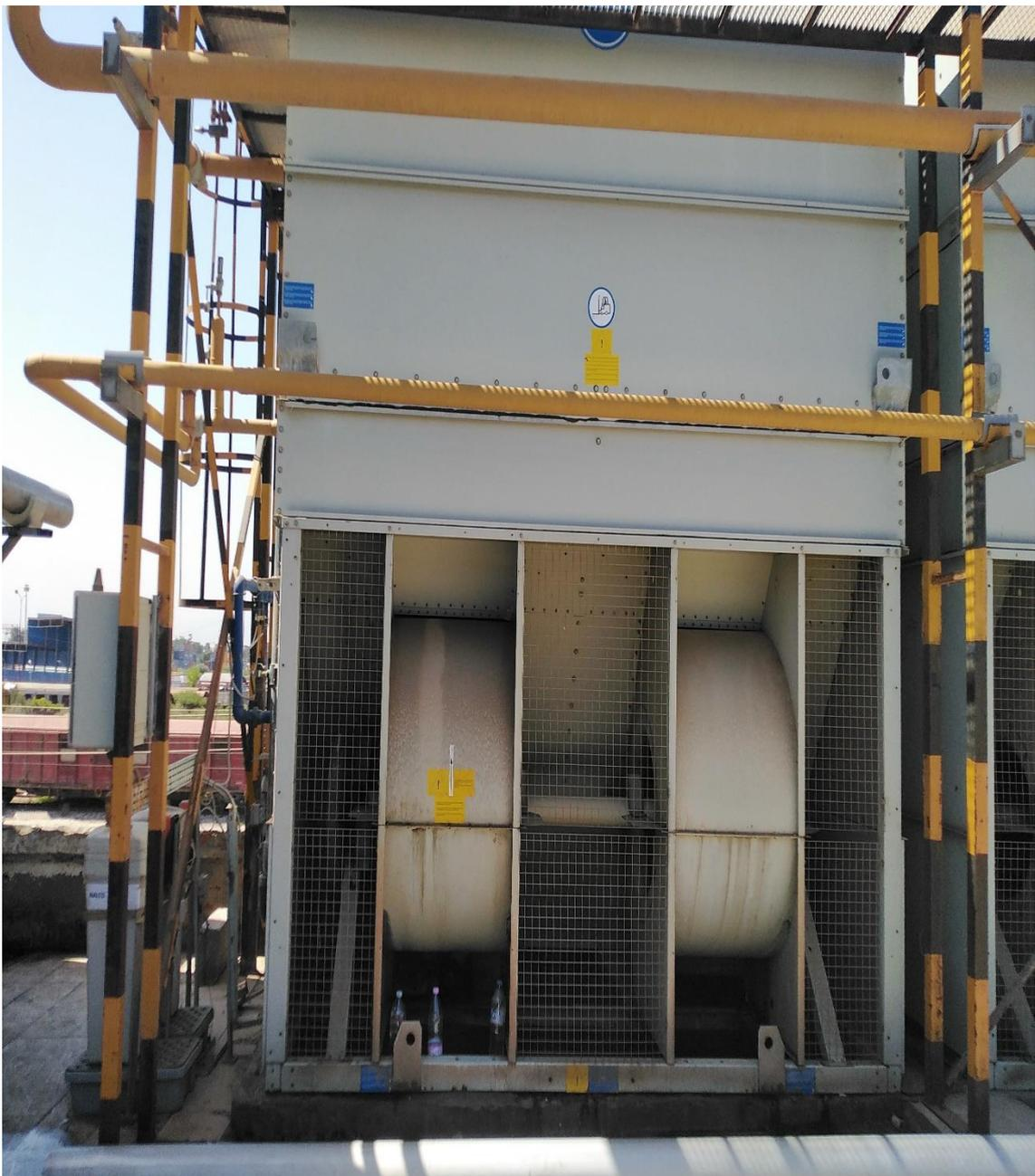
**Figure 2.11** : Une vue de face réelle d'un condenseur évaporatif.
