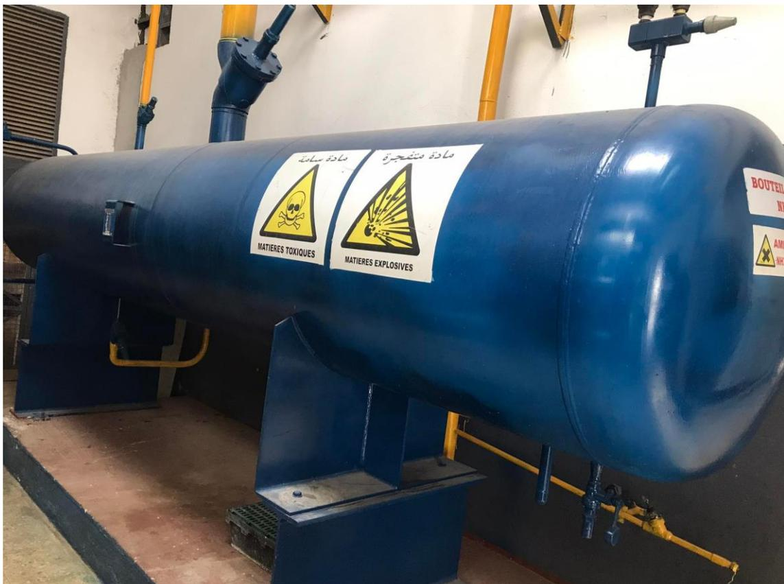
Figure 2.19 : Une vue réelle d'une bouteille accumulatrice HP.
