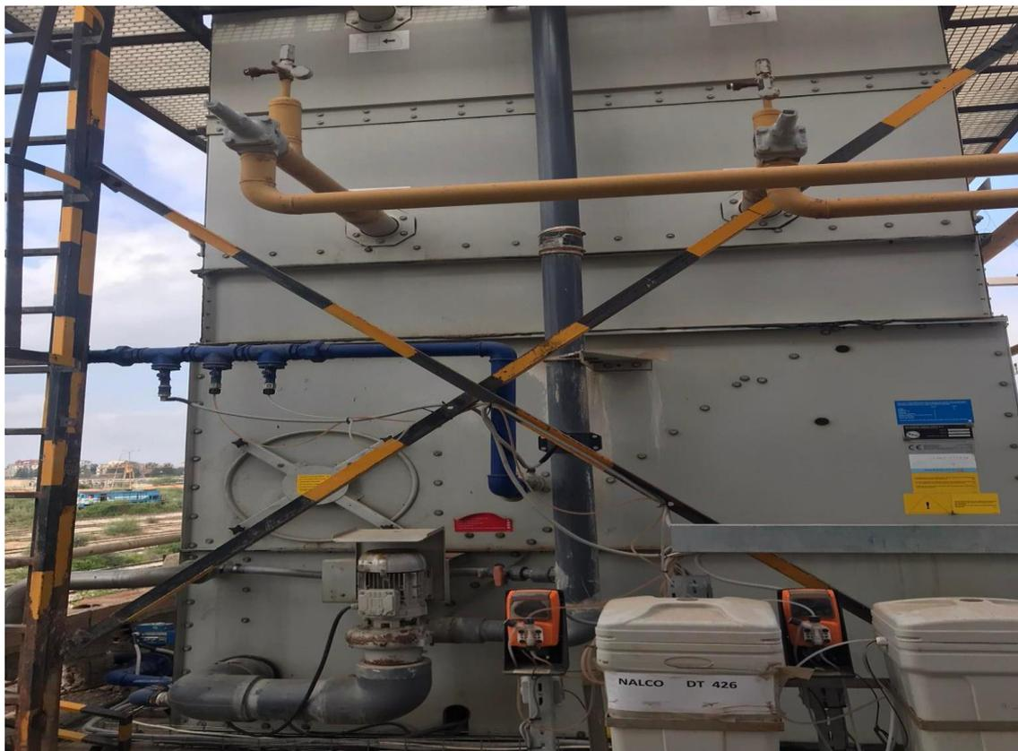
**Figure 2.12** : Une vue de côté réelle d'un condenseur évaporatif.
