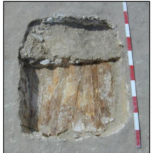
**Fig.21.** Molesme « Sur-les-Creux » (Côte-d'Or), début du I<sup>er</sup> s. ap. J.-C. Cuve à chaux. Le fond de la cuve est constitué de planches de sapin (photo Ch. Petit).
