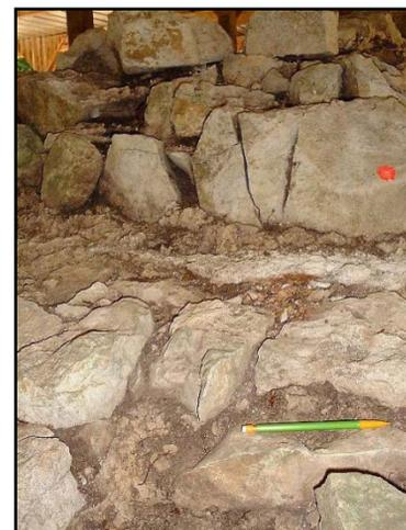
**Fig. 20. Blocage du mausolée de Faverolles et niveau de chaux**
