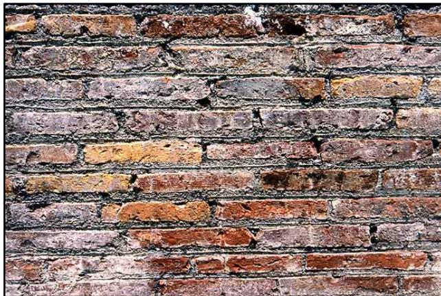
**Fig.5.** Brique avec mortier de chaux , Ostie antique ,
