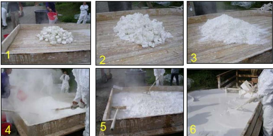
**Fig.64.** extinction de la chaux en poudre/ en pâte
