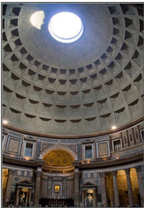
**Fig.6.** Le Panthéon de Rome, Ier siècle av. J.-C., un exemple exceptionnel d'ouvrage ayant défié intacts les siècles, l'*opus caementicium*, mortier de chaux mêlé à des matériaux tout venant, les caementa, maçonné et non coulé, réalise une maçonnerie dont la texture peut s'apparenter au béton de ciment moderne
