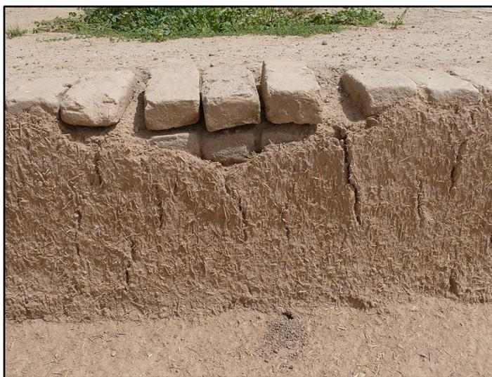
**Fig.3.** Reconstitution archéologique d'un mur. Briques de terre crue et mortier de terre fibré. Apadana de Suse. Iran
