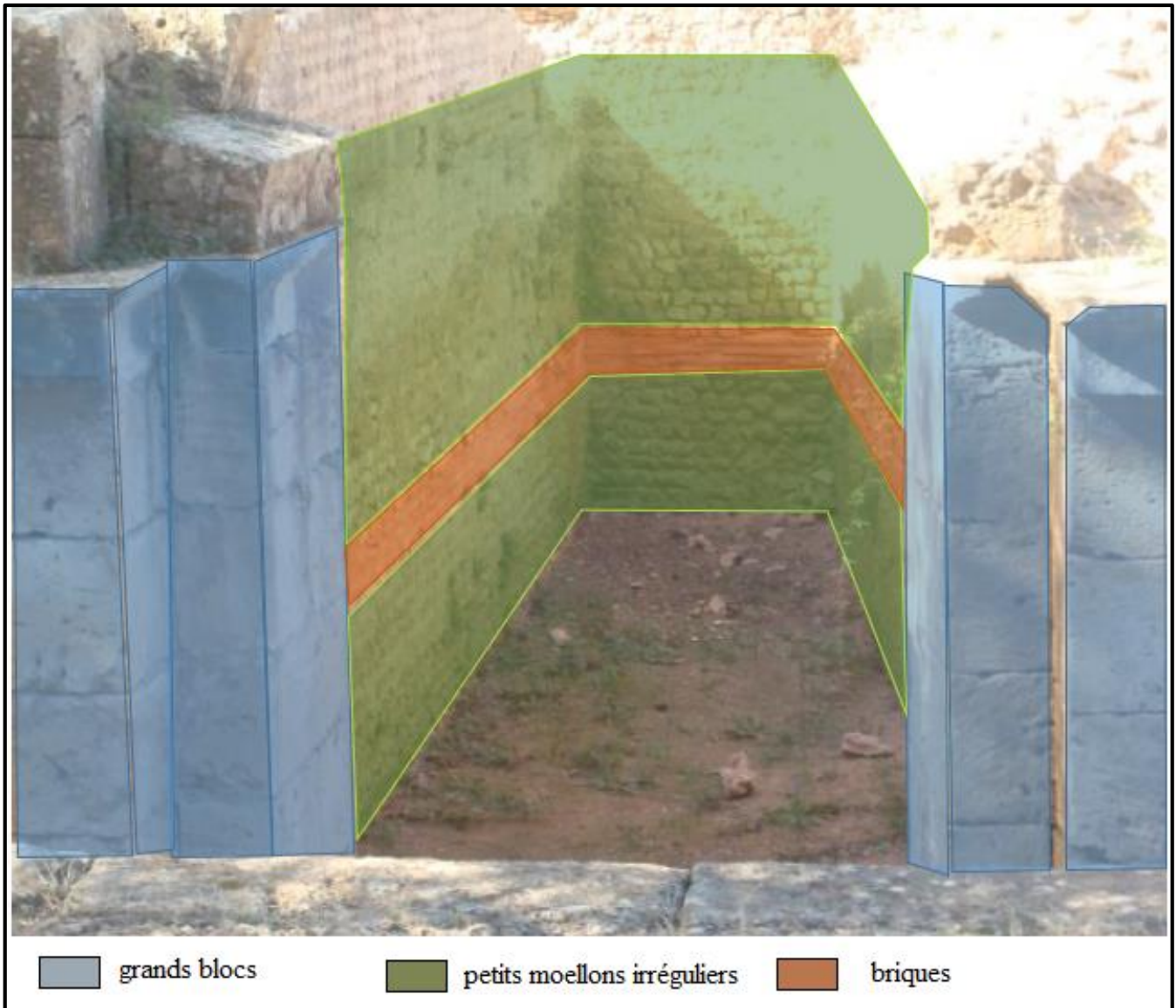
Figure 14 :l'appareillage du mur des chambres
