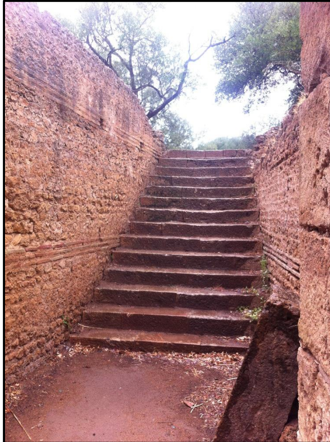
Figure 29 : escalier qui mène vers les gradins.
