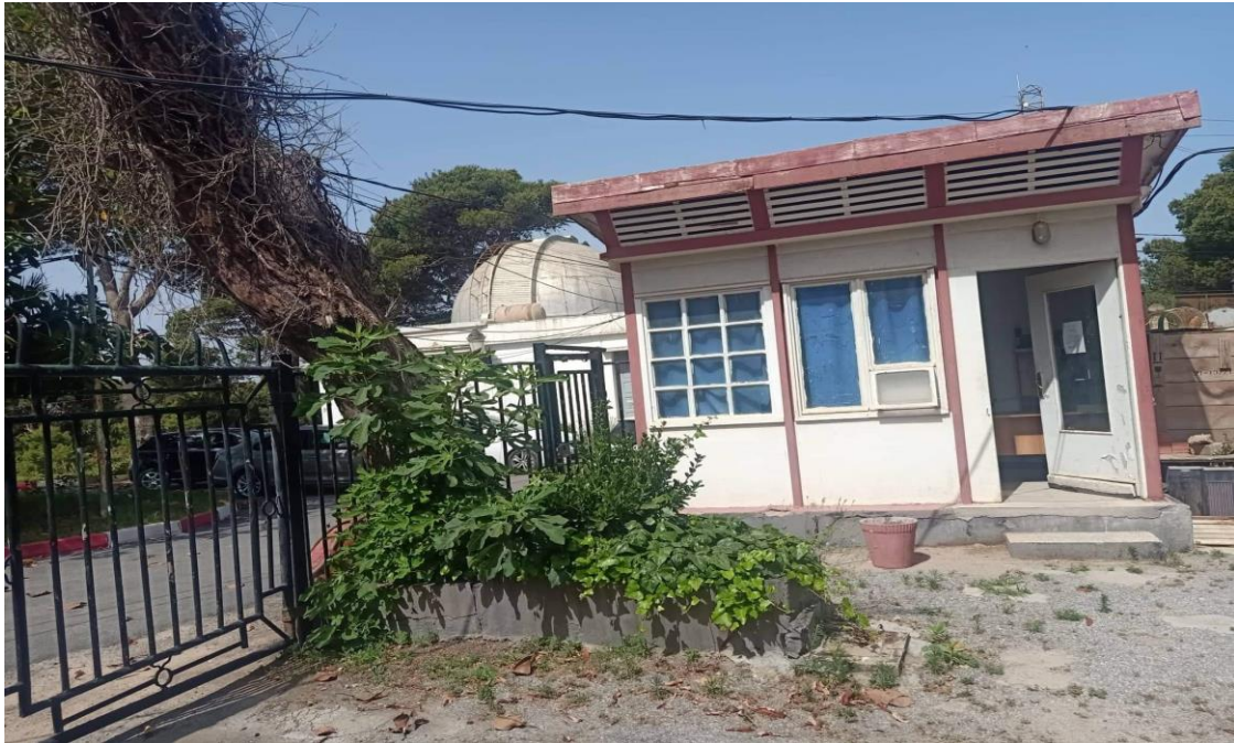
Fig.2. 9-photo réelle de local
